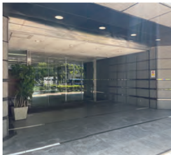
■サスセンタービル1階入口
